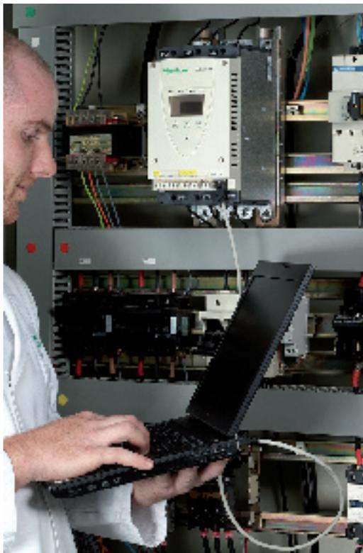
Конфигурирование ATS 22 при помощи программного обеспечения SoMove Lite
