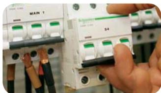
Двойной пружинный зажим для фиксации на DIN-рейке позволяет демонтировать устройство, не снимая гребёчатую шинку. Это приспособление адаптируется к новым требованиям и упрощает проведение модернизации распределительного щита.
