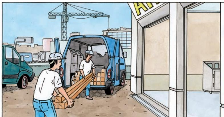
Распакуйте и разложите на полу элементы шинопровода, необходимые для монтажа первой линии. Проверьте расположение блока подачи питания. Он должен располагаться как можно ближе к электрощиту.
