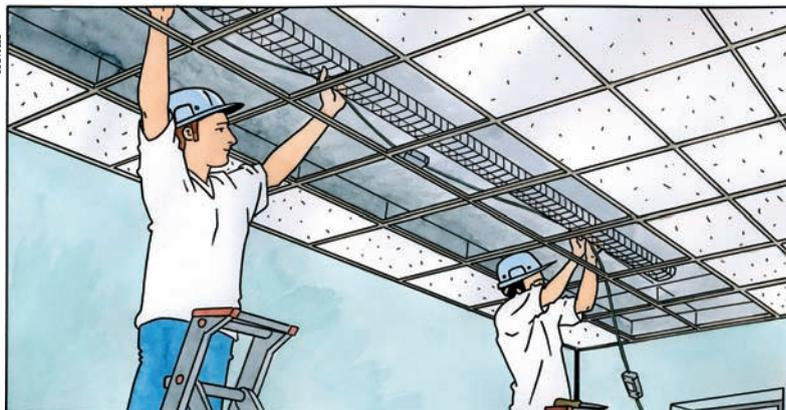
Прикрепите шинопровод Canalis KDP к кабельному лотку с помощью зажимов.
