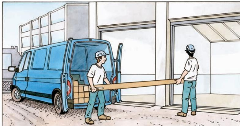
Распакуйте и разложите на полу элементы шинопровода, необходимые для монтажа первой линии.
