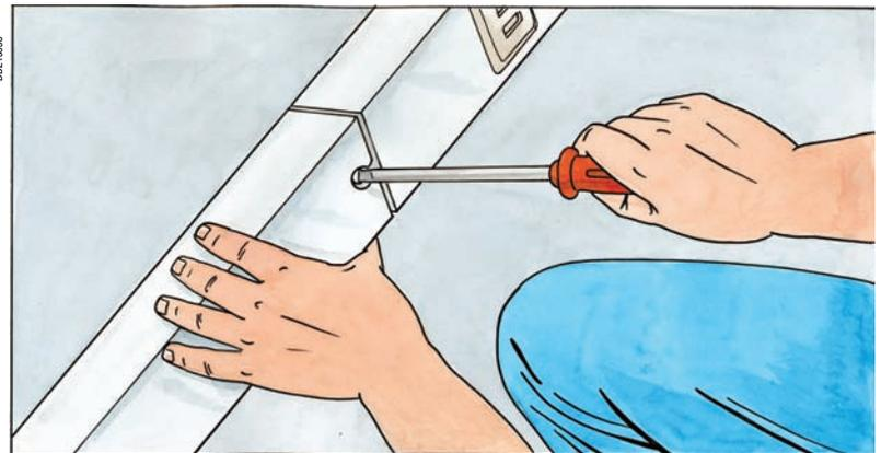
Поднимите и установите сегмент линии в крепежные скобы. Они спроектированы для максимального освобождения монтажника от весовых нагрузок. Шинопровод находится на месте, как только элементы КВА помещены в скобы.
