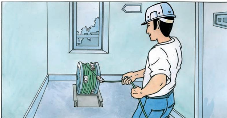
Выполните монтаж шинопровода Canalis KDP над подвесным потолком. Если монтируется новый подвесной потолок, то рекомендуется сначала производить монтаж шинопровода Canalis KDP.
