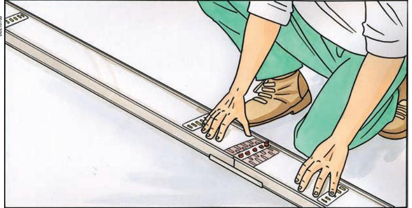
Установите крышку и соедините между собой секции с помощью системы механического и электрического соединения.
