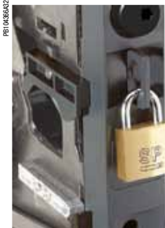
Блокировка в положении «выквачено» навесным замком
