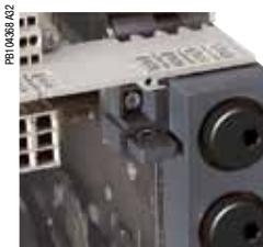
Блокировка вкатывания при открытой дверце
