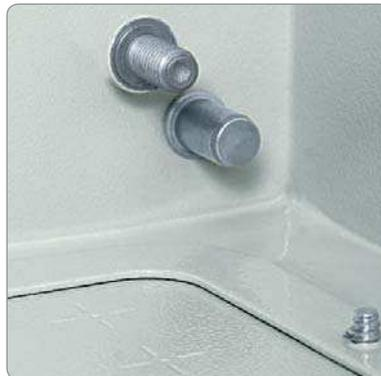
Монтажная плата устанавливается на 4 ступенчатых болтах 10 мм
