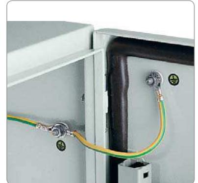
Болты заземления, приваренные к корпусу и двери
