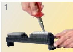
1 Снятие перемычки с клеммника фазы/нейтраль
